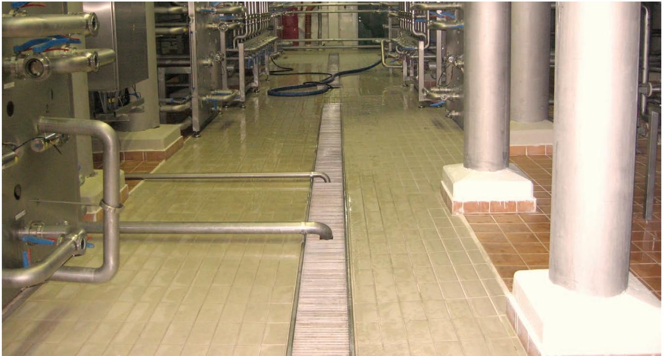
Производственные сточные воды содержат органические вещества, которые служат питательной средой для развития патогенных микроорганизмов. Поэтому стоки необходимо быстро и тщательно удалить из цеха. Именно эту задачу выполняют системы водоотвода из нержавеющей стали INOX PARK, состоящие из лотков трапов и решёток различных модификаций.
