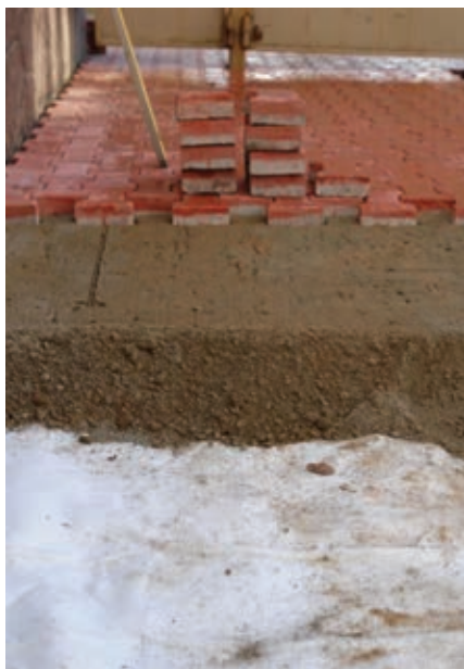
Мощение тротуарной плиткой
