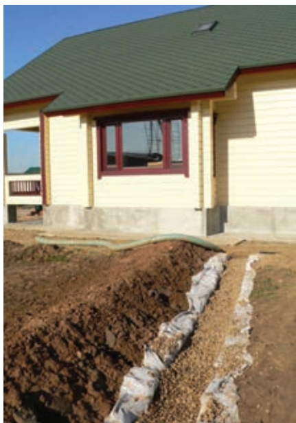
Устройство дренажной системы
