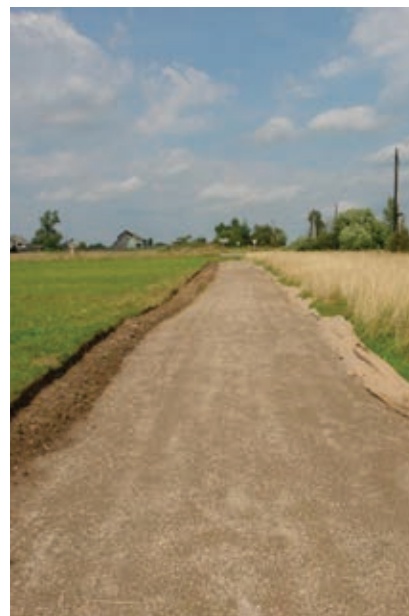
Строительство сельской дороги
