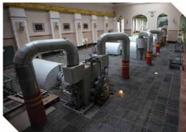
Применение настила на площадках обслуживания
